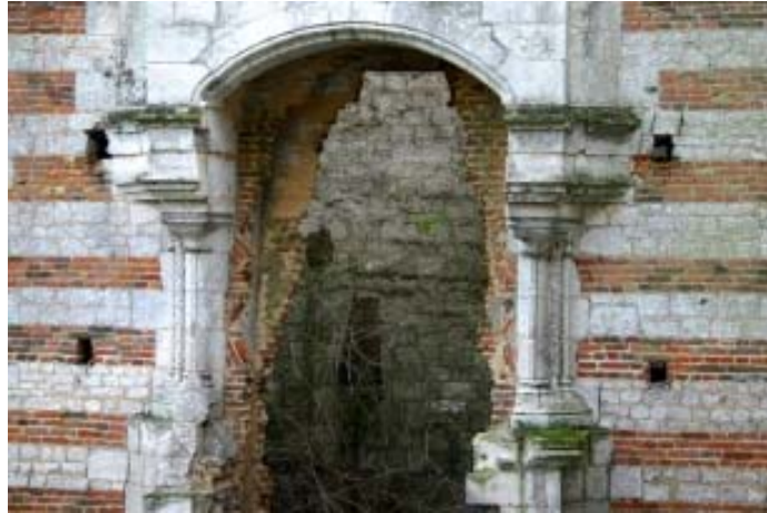
Figure 59 : Cheminée du niveau 2 de la Grande chambre
