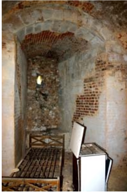
Figure 61 : Vue intérieure de la grande baie du niveau 2 de la Tour Collecte
