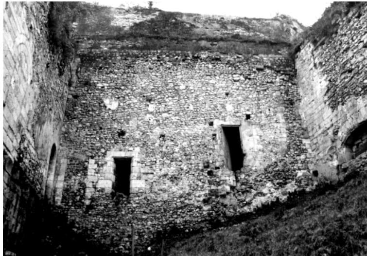
Figure 50 : Vue intérieure du mur Sud de la Grande salle
