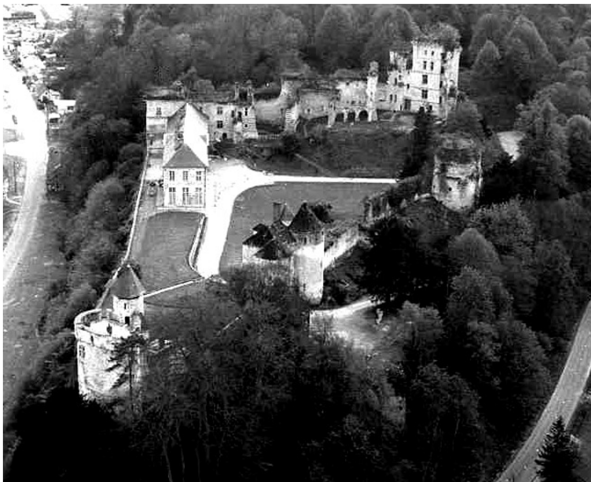
Figure 26 : Vue aérienne du château, prise depuis le Nord. Au fond, de gauche à droite, la Tour carrée, le château neuf, la Basse salle, les ruines de la Chambre monseigneur, celles de la Grande salle, puis les colonnes de la Chambre aux chevaliers, enfin la Grosse tour. Au premier plan, la Tour de l'aigle, puis la porte devers la ville et la Tour du lion
