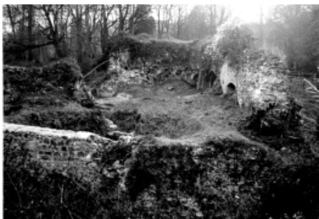
Figure 34 : Vue du boulevard depuis l'ouvrage trapézoïdal. Photographie prise en 1993, à une époque où le boulevard venait d'être dégagé par l'association de sauvegarde
