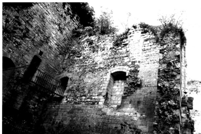
Figure 53 : Vue du mur gouttereau Est de la Grande salle, pris depuis l'Est
