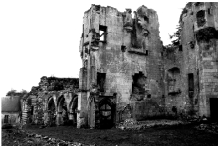
Figure 38 : Vue des ruines de la Chambre aux chevaliers. De droite à gauche, la tourelle d'escalier derrière la tour carrée, le mur d'enceinte, le refend entre la partie garde-manger et la partie cuisine se terminant par un contrefort de 1410-12, puis les trois arcades primitives de la partie cuisine.
