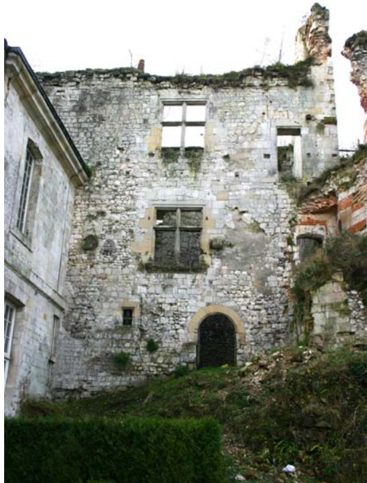
Figure 64 : Vue de la façade Nord de la Basse salle
