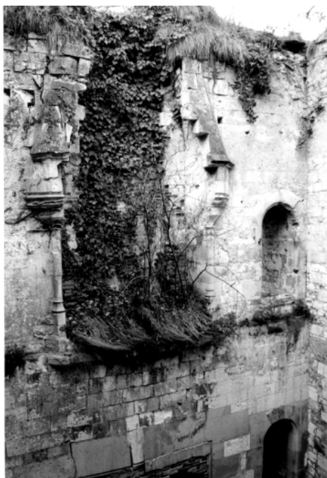
Figure 65 : Vue de la cheminée du niveau 2 de la partie garde-robe de la Basse salle
