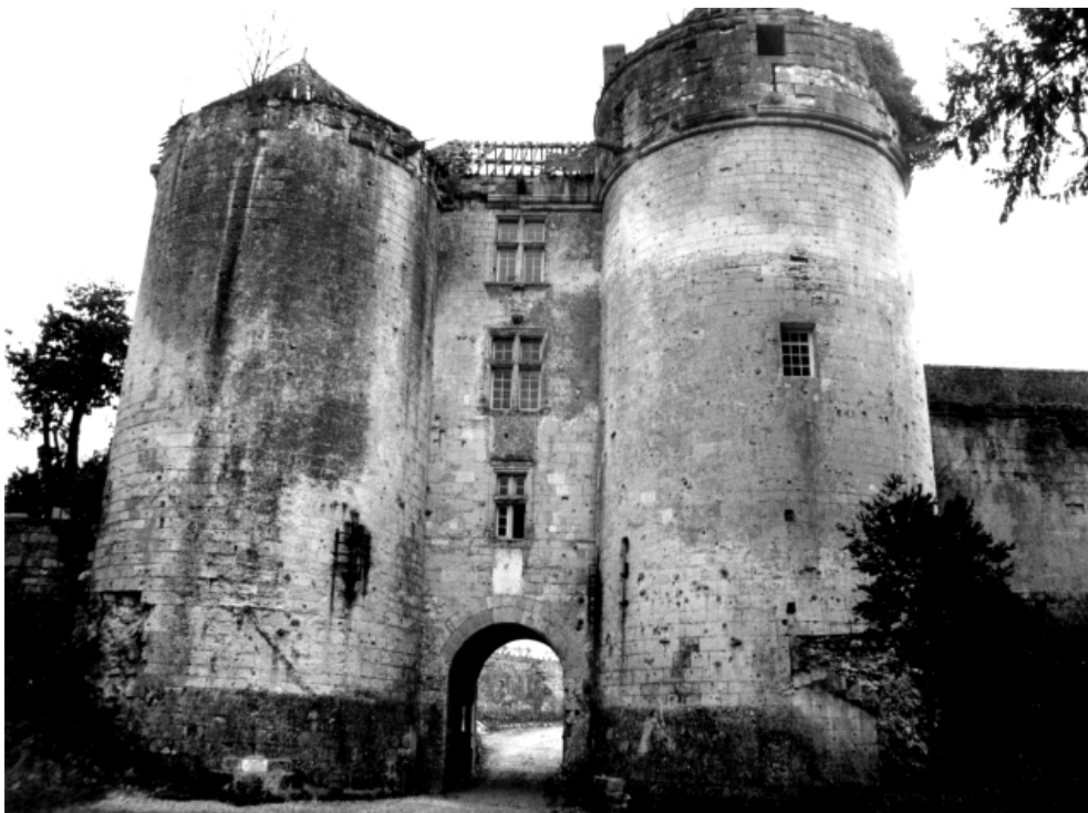
Figure 9 : Vue actuelle de la porte d'entrée
