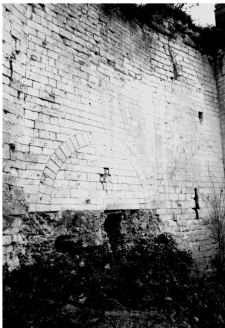
Figure 49 : Vue du mur extérieur de la Grande salle, avec le pan central qui correspond à l'emplacement de l'ancienne petite tour carrée devers le bois
