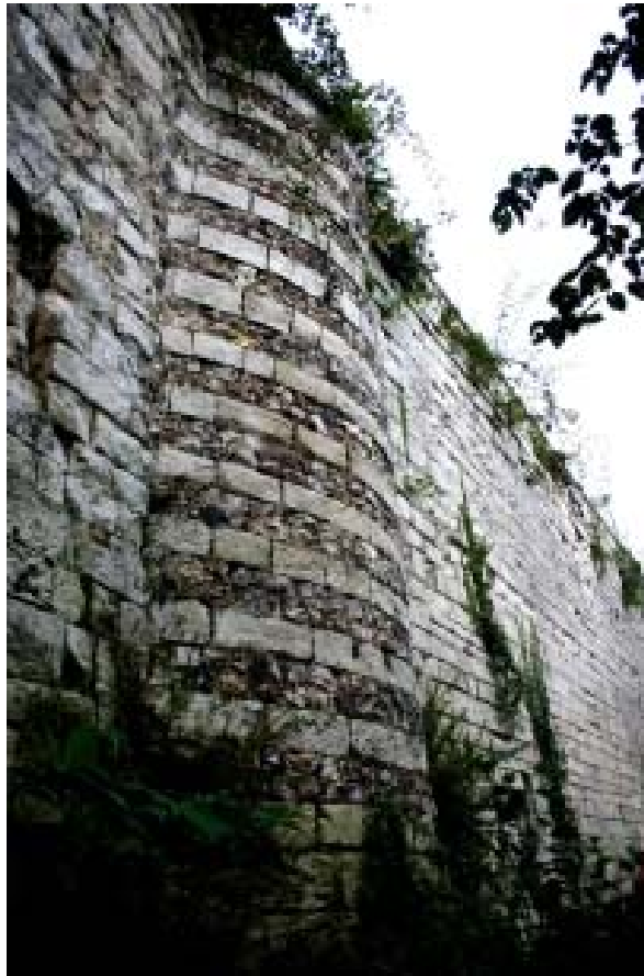
Figure 16 : Vue de la tourelle circulaire flanquant la grande courtine orientale
