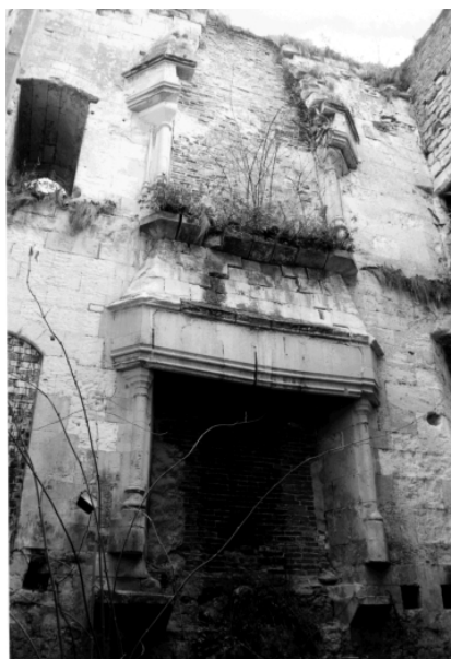
Figure 66 : Vue des cheminées dans la partie chambre de la Basse salle
