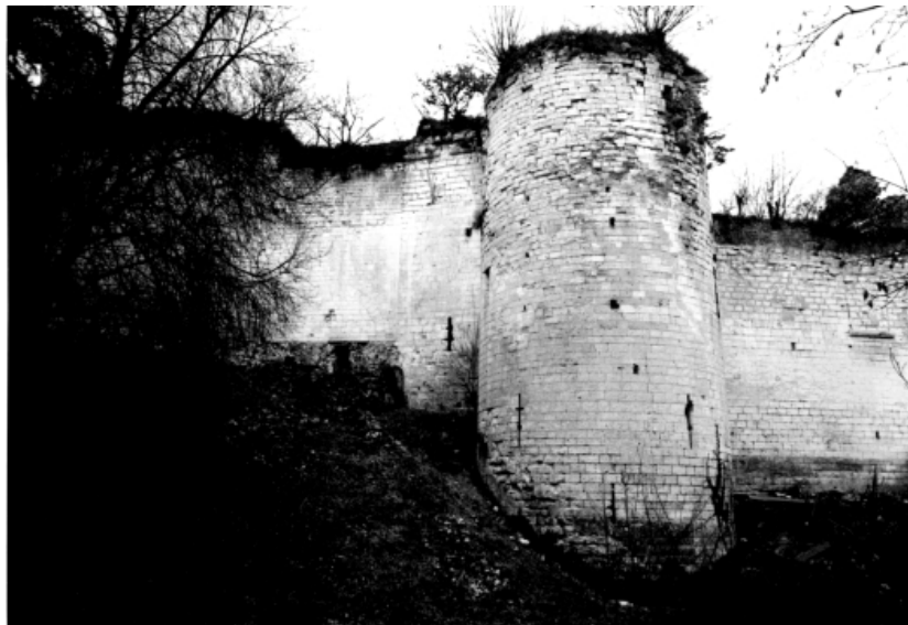
Figure 60 : Vue de la Tour Collecte prise depuis le Sud-Ouest
