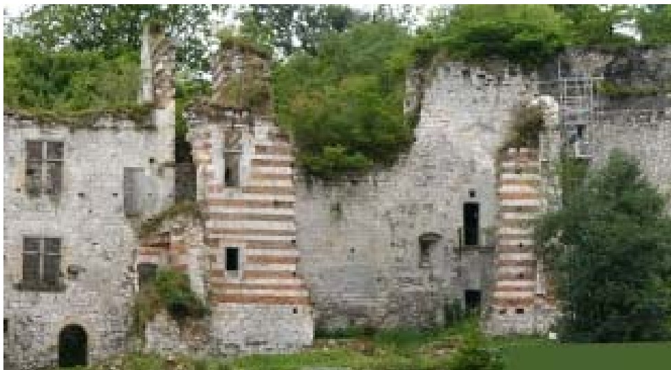
Figure 56 : Vue de la façade de la Grande chambre
