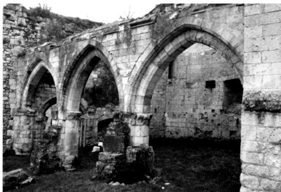
Figure 39 : Vue de la file d'arcades de la Chambre aux chevaliers
