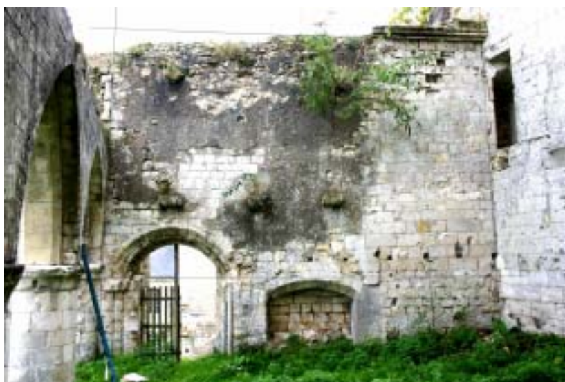
Figure 43 : Vue du mur pignon oriental de la Chambre aux chevaliers. De gauche à droite, la porte de la Grande salle, le passe-plats, et en haut le couloir des latrines.
