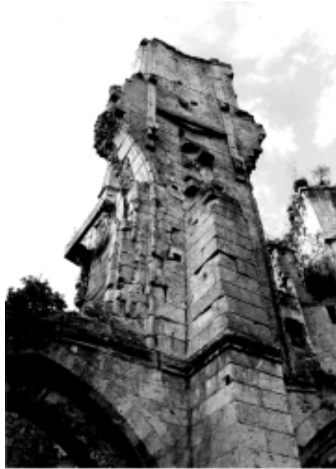
Figure 40 : Vue des restes de fenêtres des étages de la Chambre aux chevaliers, de part et d'autre du contrefort séparant la partie sur la cuisine de la partie sur le garde-manger
